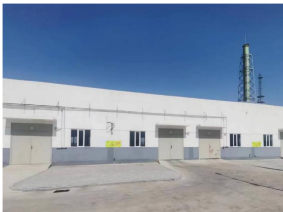
危废暂存库外部照片
